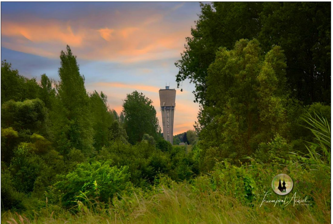
Dijkzicht met watertoren
